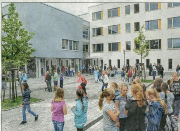
Altbau und Neubau vereinen sich am Schönebecker Hermann-Gymnasium in perfekter Art und Weise.
